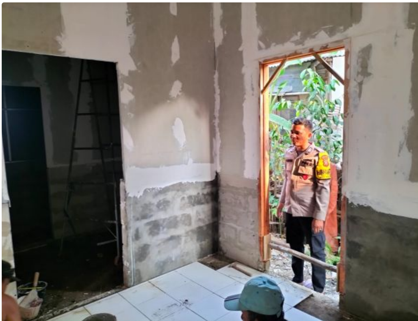
Pembangunan Rutilahu di Kecamatan Terisi Terus Berjalan Lancar
